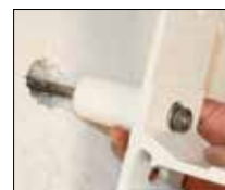
5. Bei Durchsteckmontage: Konsole mit RECA Dimos montieren.
