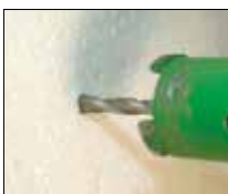
1. Loch in Isolierung bohren.
