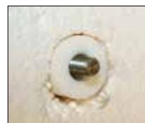
4. Bei Vorsteckmontage: Dübel vormontieren, RECA Dimos montieren.
