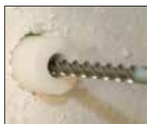
2. Loch in Untergrund bohren (evtl. RECA Dimos als Zentrierhilfe verwenden).
